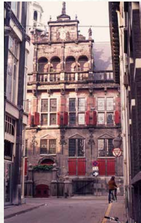
Voorgevel van het oude stadhuis aan de Groenmarkt. De foto is genomen vanuit de Nieuwstraat, omstreeks 1980. Fotograaf C.L. van Pelt
