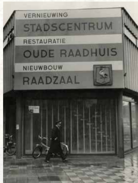
Werzaamheden voor de bouw van de nieuwe raadzaal aan de Groenmarkt gaan beginnen. Mei 1968, fotograaf Hans de Bakker
