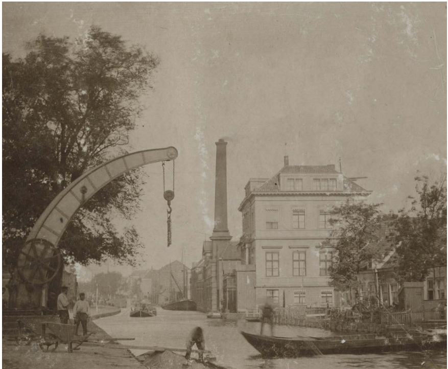
1900. De pletterij van de firma Enthoven aan de Pletterijkade.
