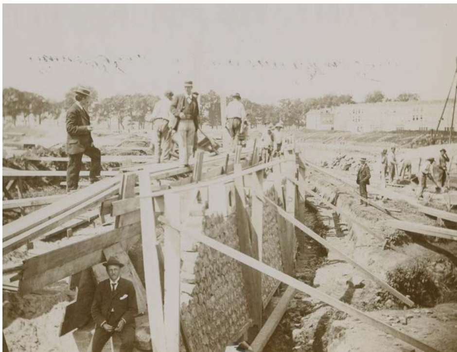
1895 Aanleg van de Laakhaven. Fotograaf onbekend
