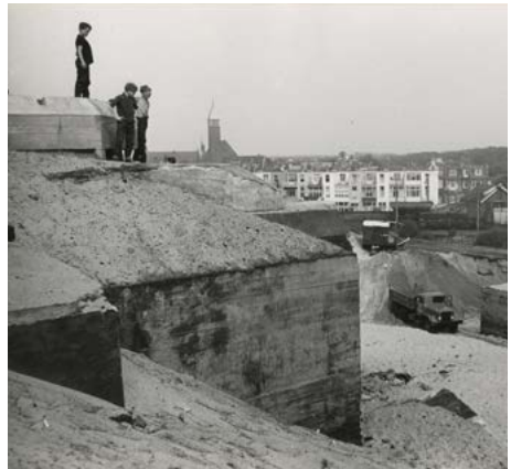
Duitse bunkers tevoorschijngekomen bij het afgraven van het duin aan Lindoduin, mei 1964 Foto door Stokvis
